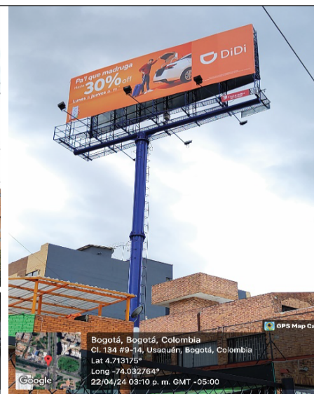
Foto 3. Vista en detalle del panel publicitario instalado.
